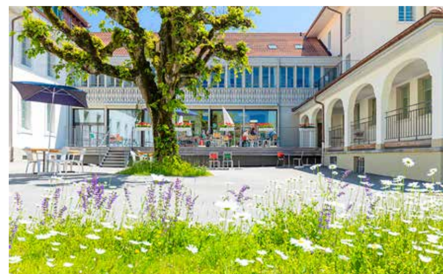
Blick in den schmucken Innhof des Alters- und Pflegeheims Kühlewil. Foto: zvg
